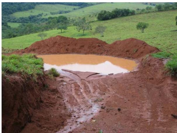
**Figura 6.7 – Bacia de captação de enxurrada.**
